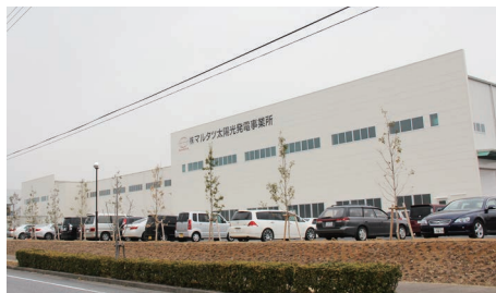
太陽光発電設備や防音設備を備え 環境に配慮された工場建物
