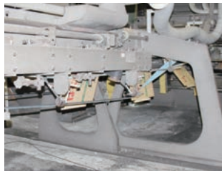
印刷・型抜き後、折り曲げ加工
