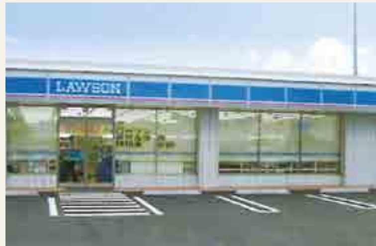
工事の精度・スピードともに依頼主の期待に応える
